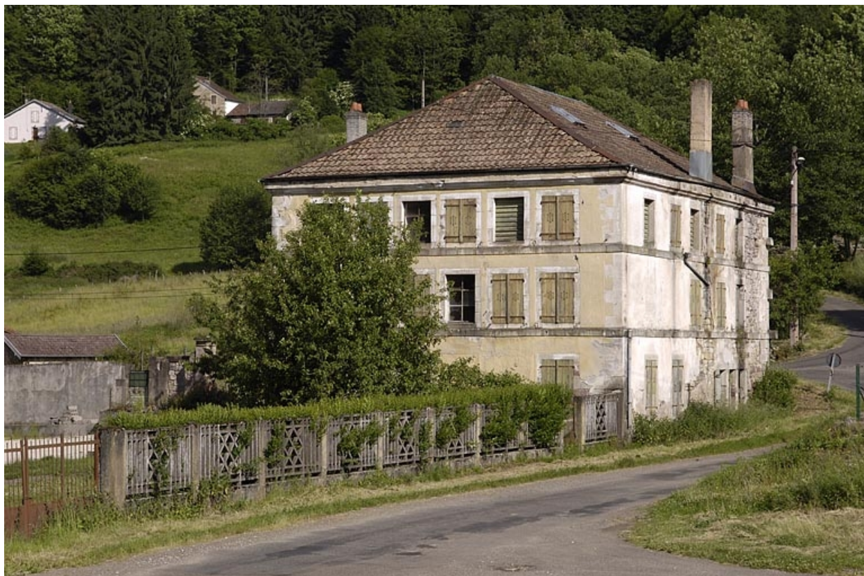
Ancien logement ouvrier vu depuis le sud-est.
