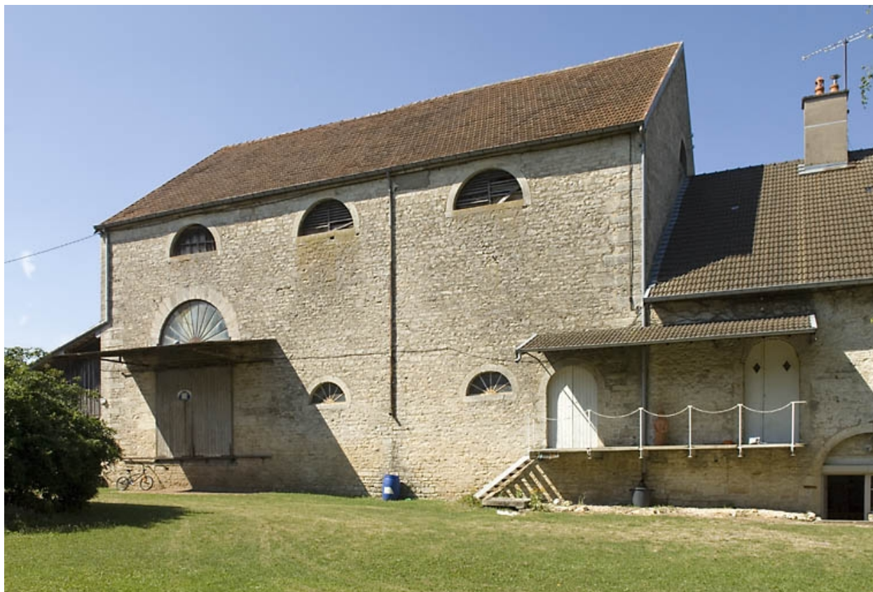
Façade sud du haut fourneau.
