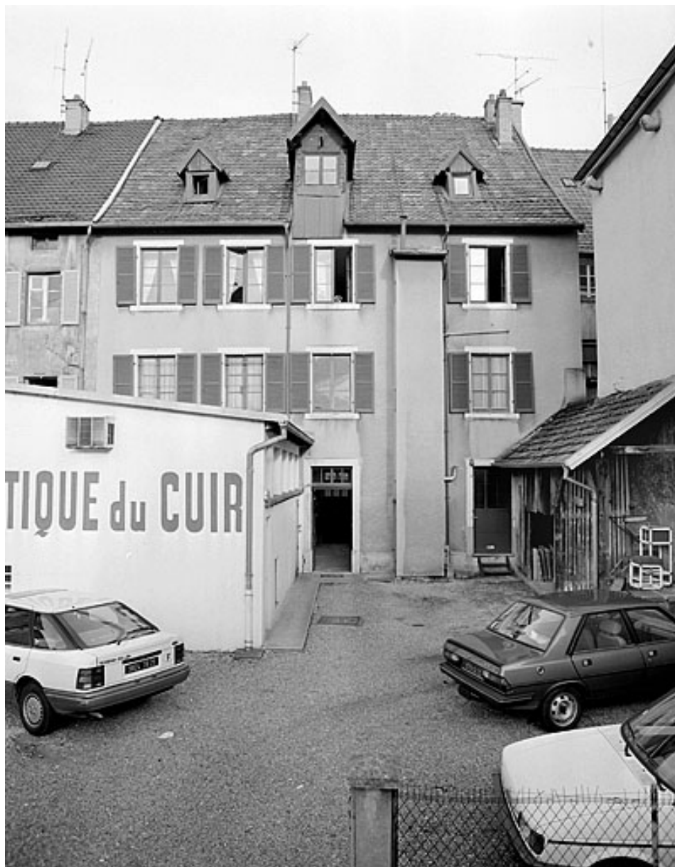
Façade sur cour.
