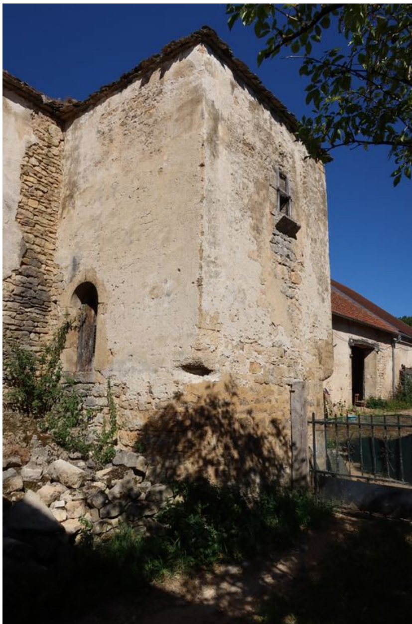
Détail du pigeonnier depuis le sud-est.
