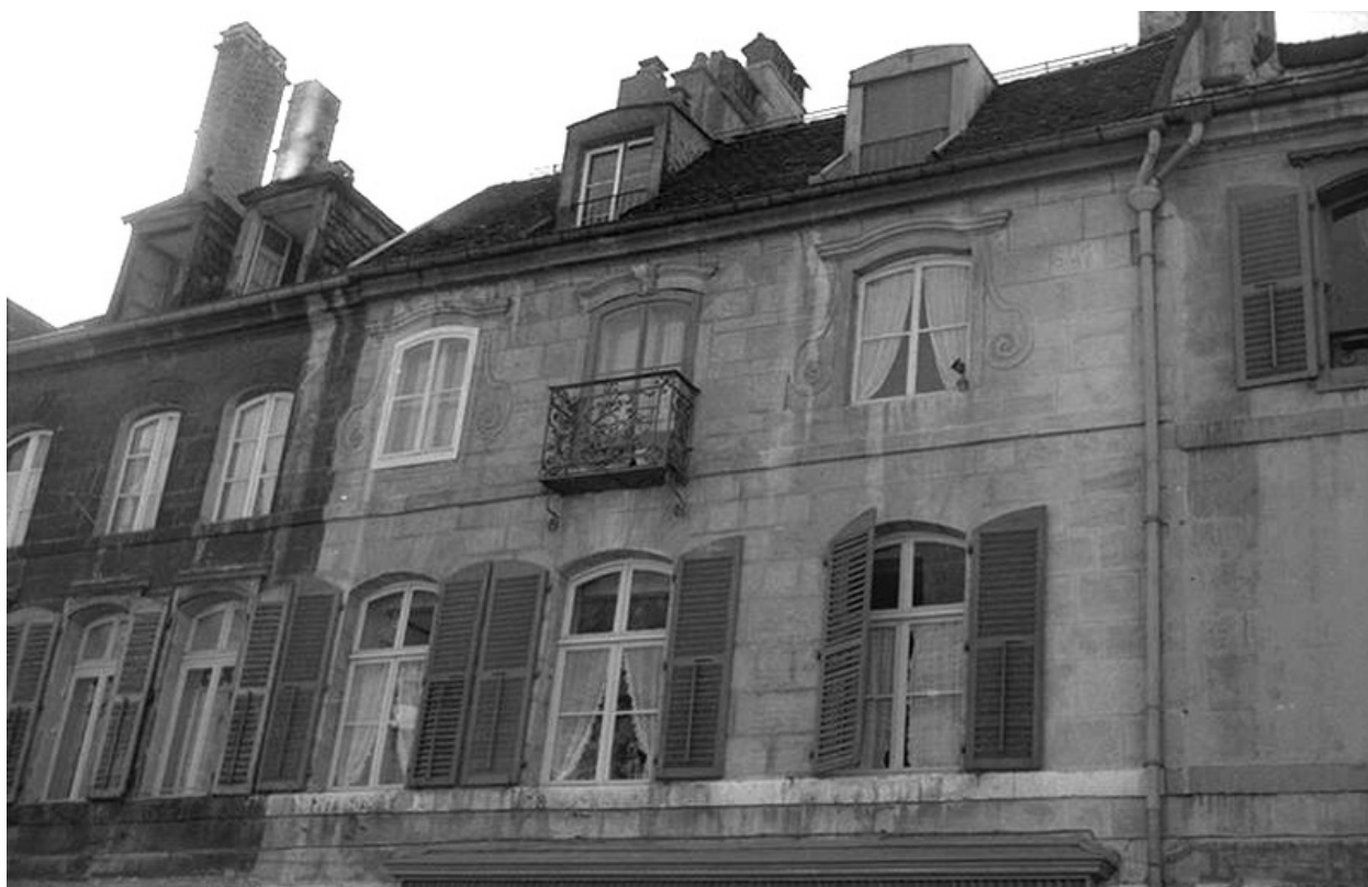
Façade antérieure : les étages.
