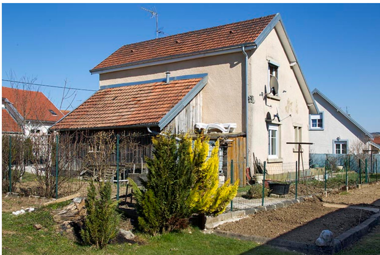
Façades postérieure (pignon) et latérale droite.
