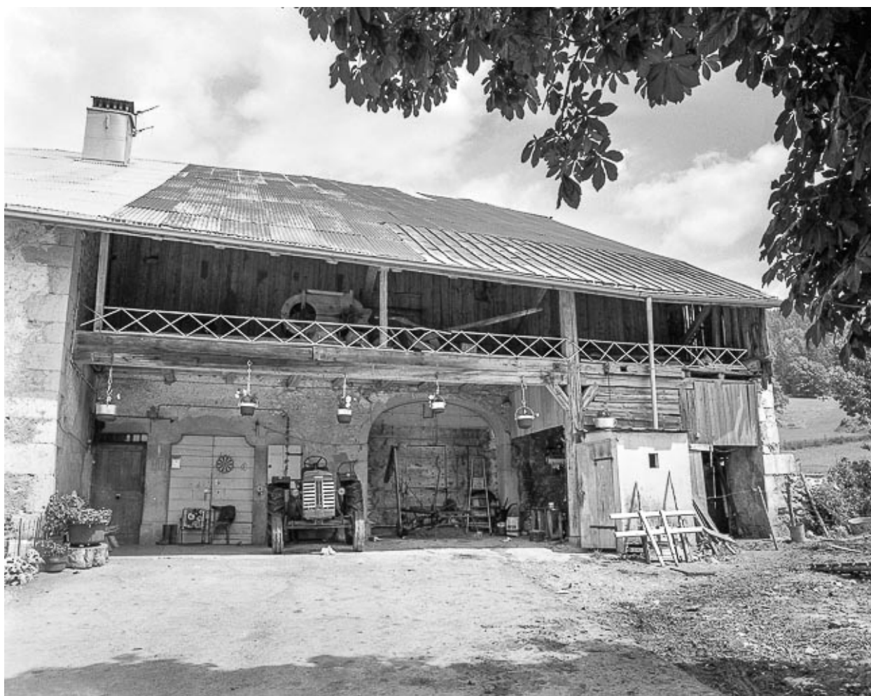
Une ferme avec portes d'entrées sur goutterot.
