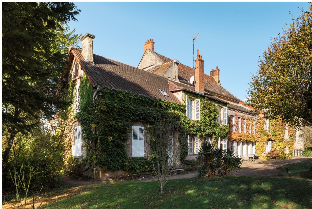
Le logis vu depuis le sud-ouest.
