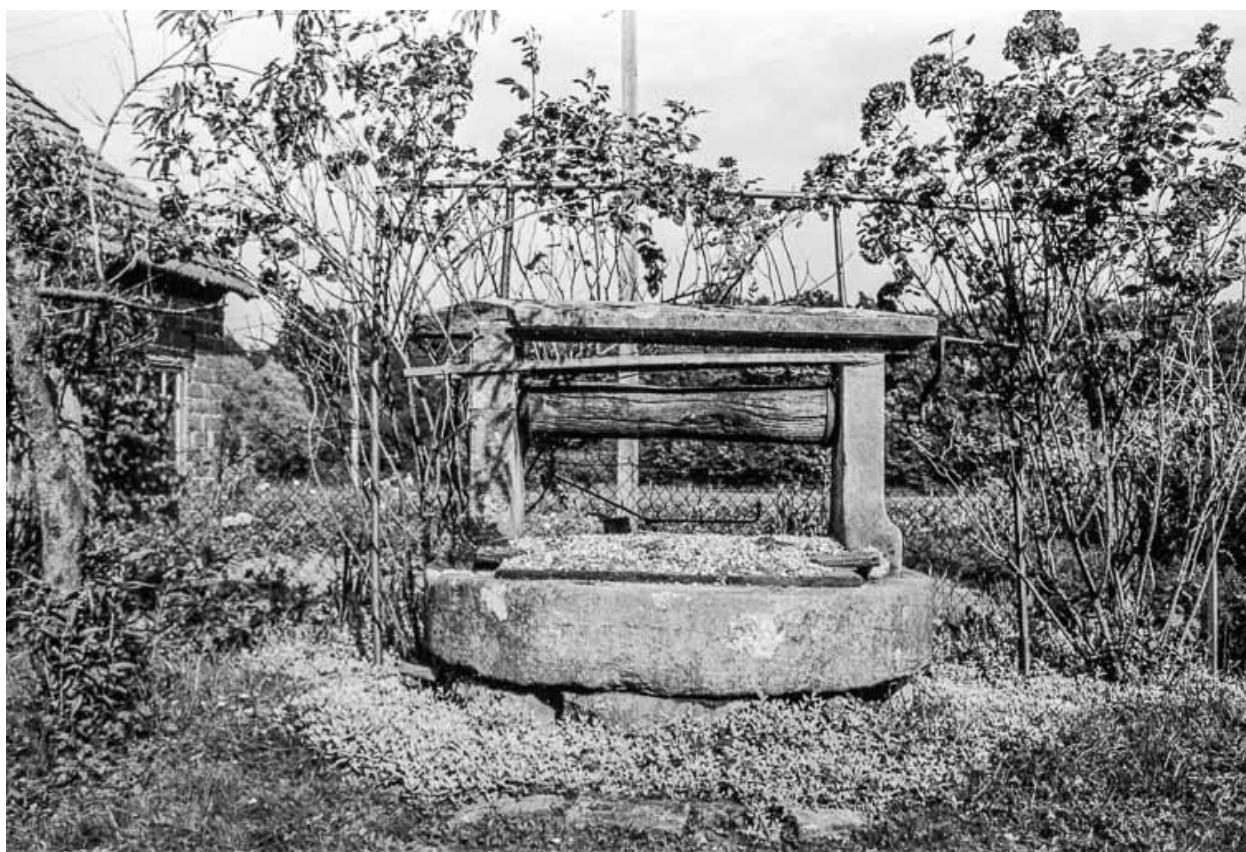
Ferme cadastrée 1956 A1 169 : puits.
