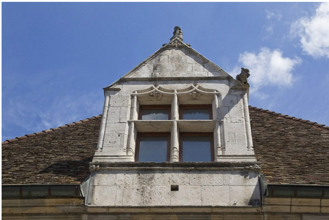
Façade antérieure, lucarne : vue d'ensemble.
