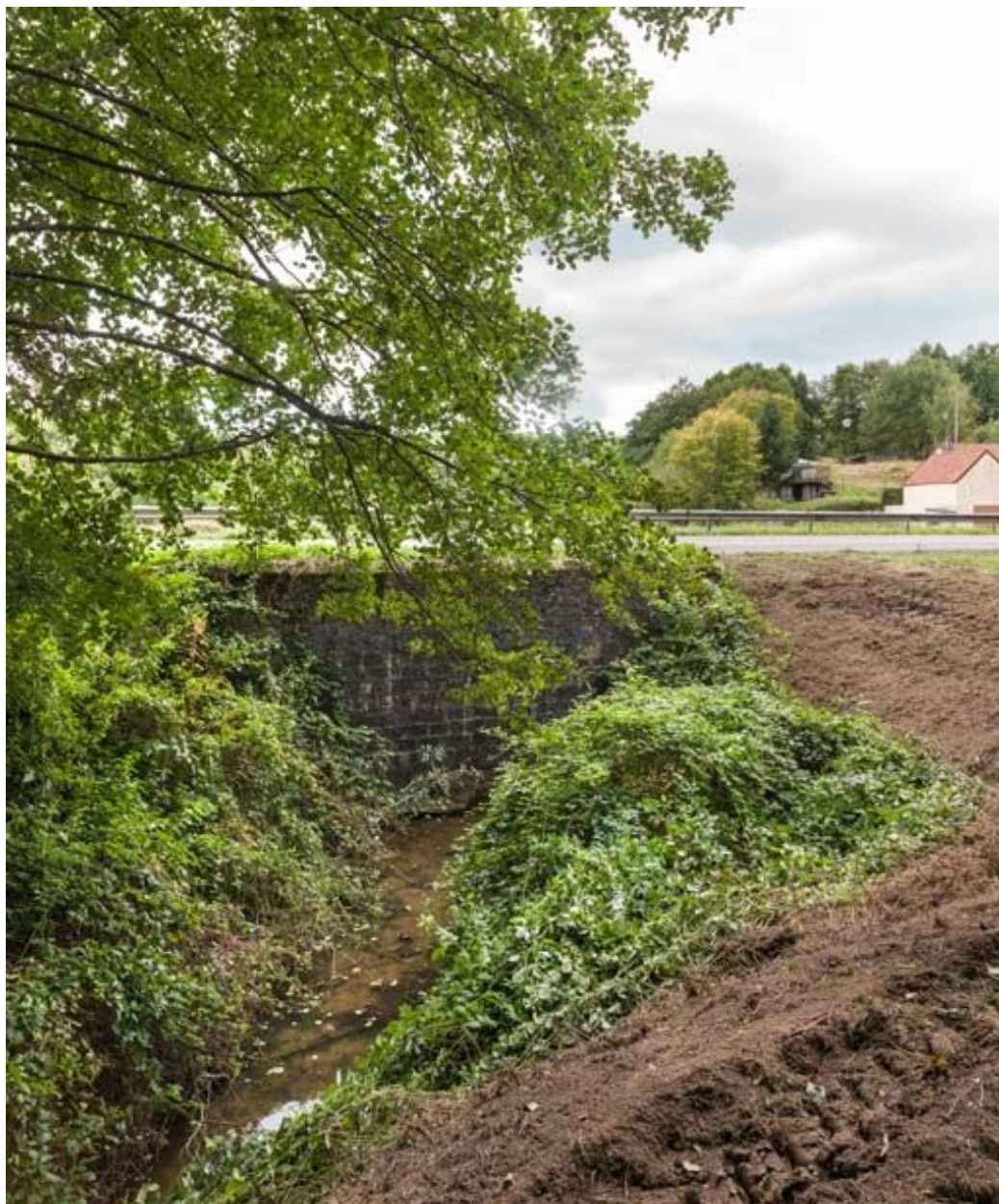
Vue de l'aqueduc.
