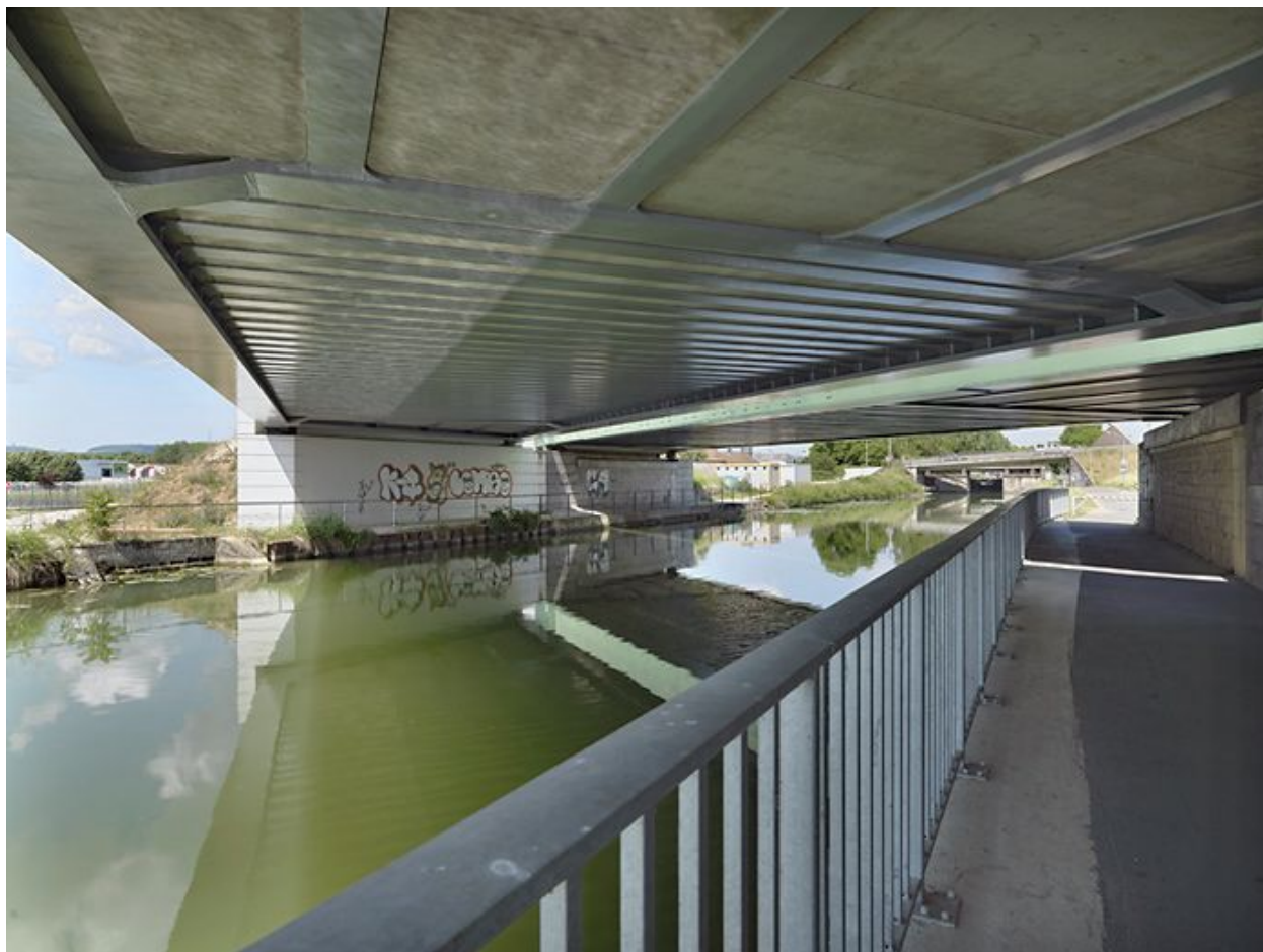
Vue du dessous du tablier.
