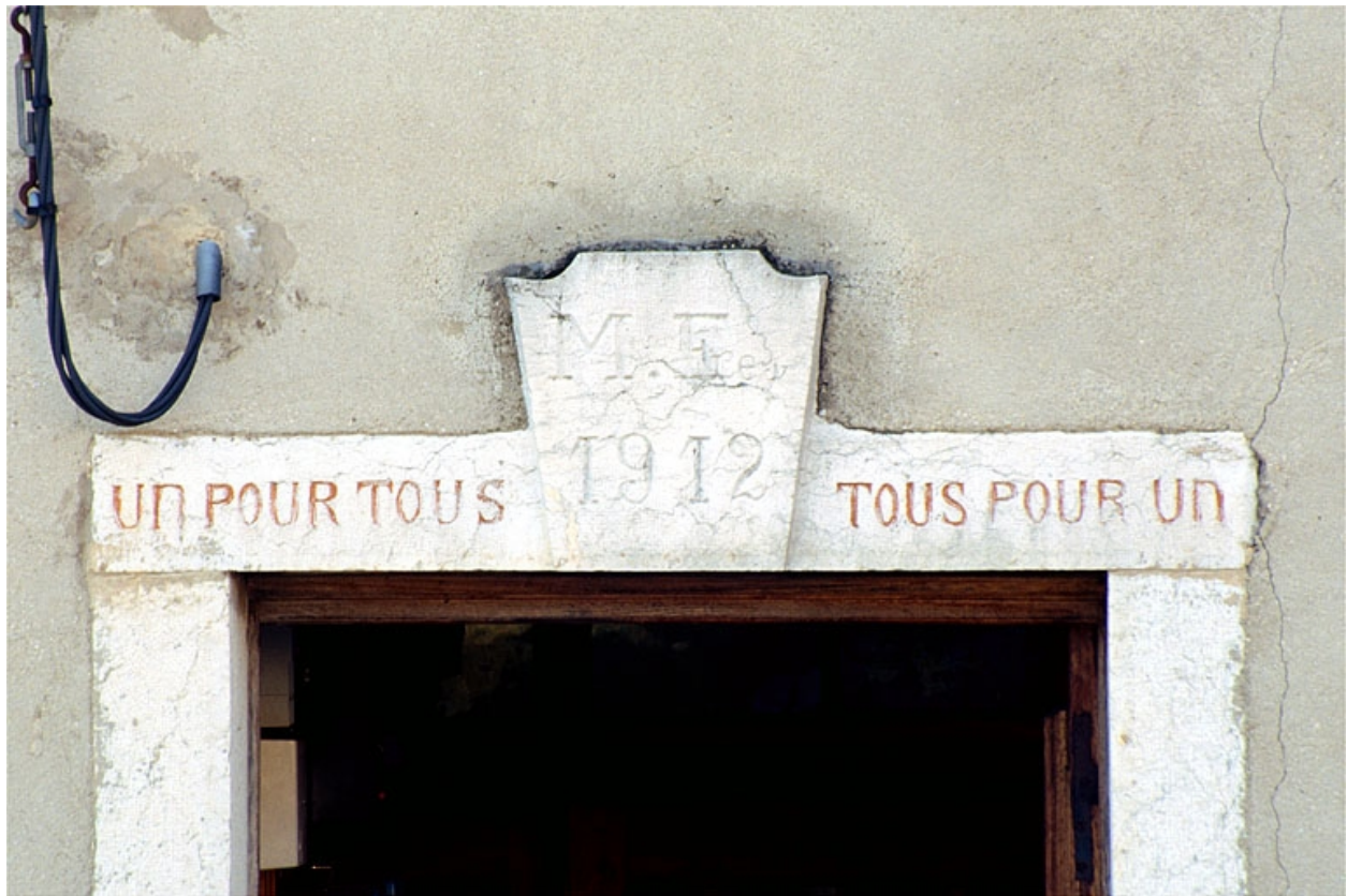
Linteau de la porte d'entrée.
