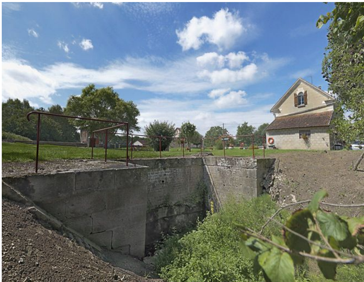
Maçonnerie de l'entrée de l'aqueduc.
