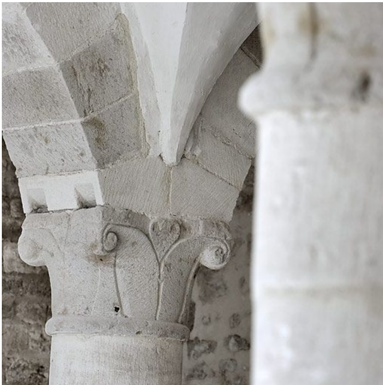
Salle voûtée, détail.
