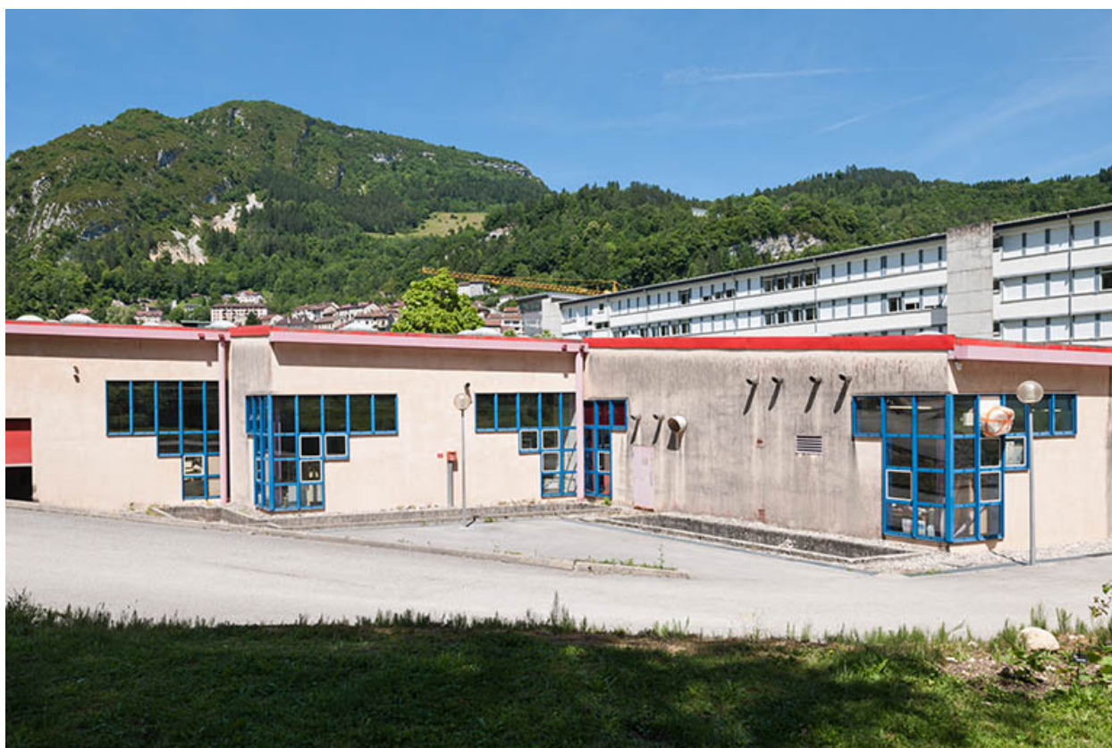
Atelier, ancien atelier mécanique : façade latérale sud.
