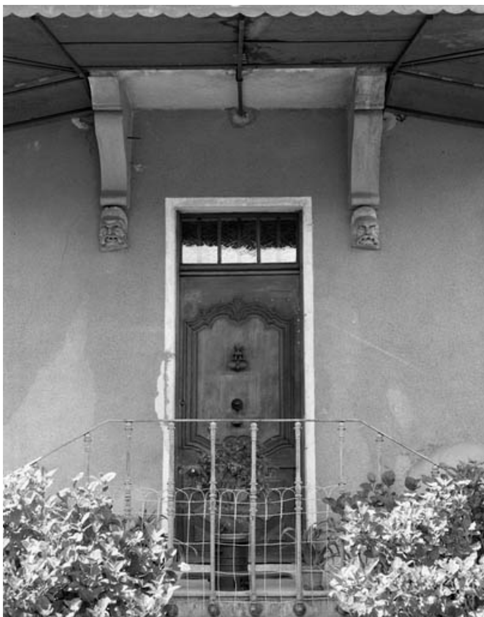
Détail de la porte d'entrée.
