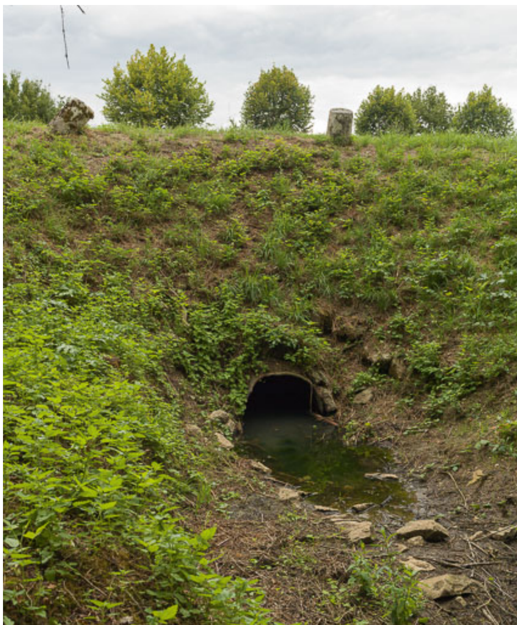
Vue de l'aqueduc.
