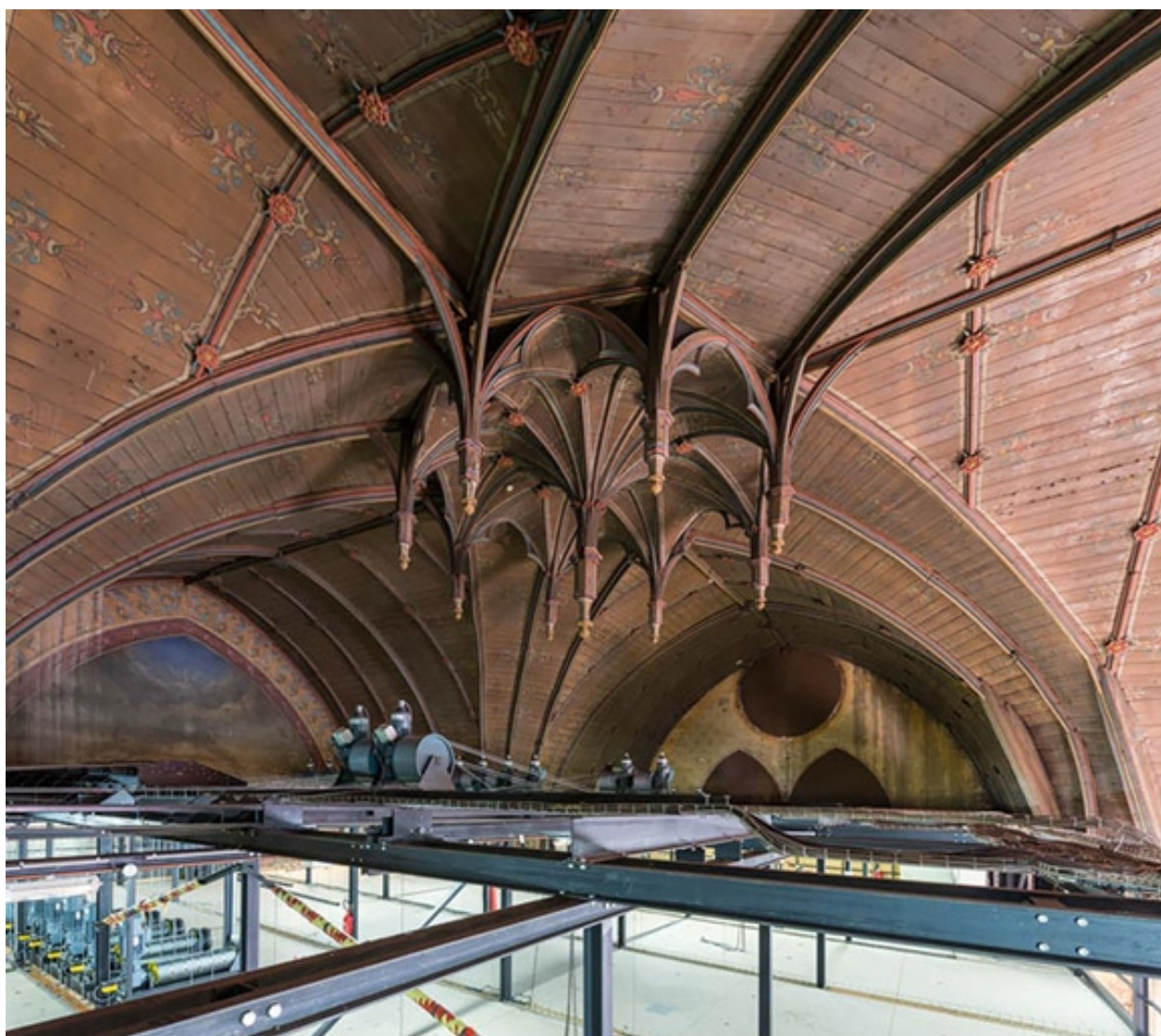
Croisée du transept : charpente lambrissée.
