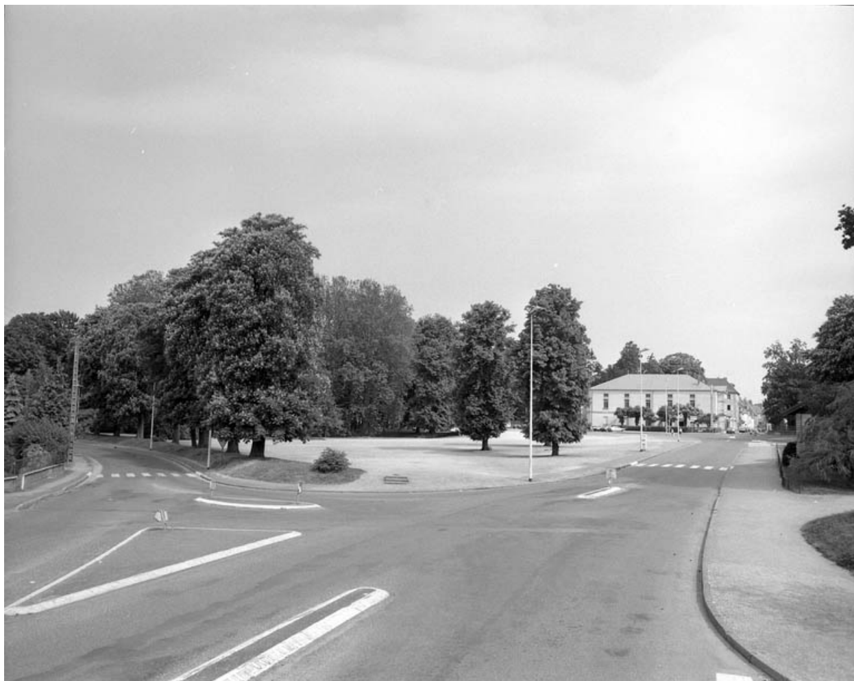
Vue d'ensemble éloignée.
