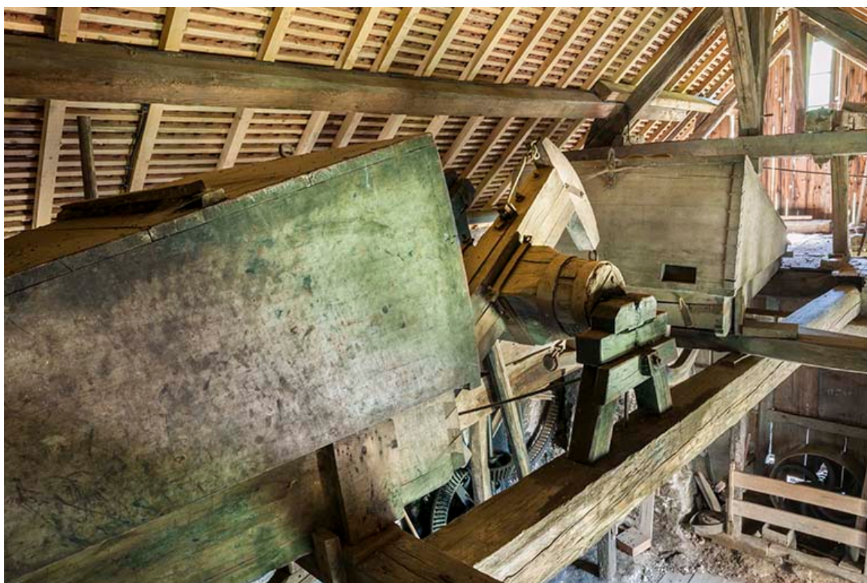
La machine soufflante vue du dessus.
