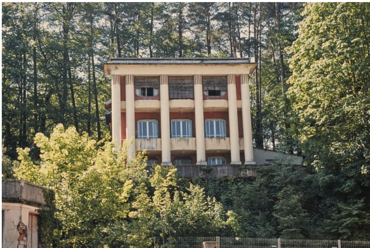
Façade nord, vue de face.
