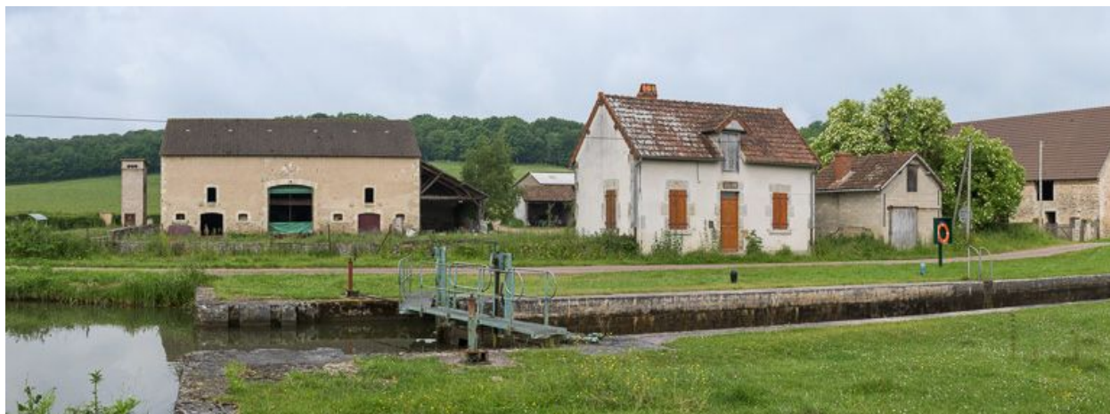
Vue d'amont du site d'écluse.
