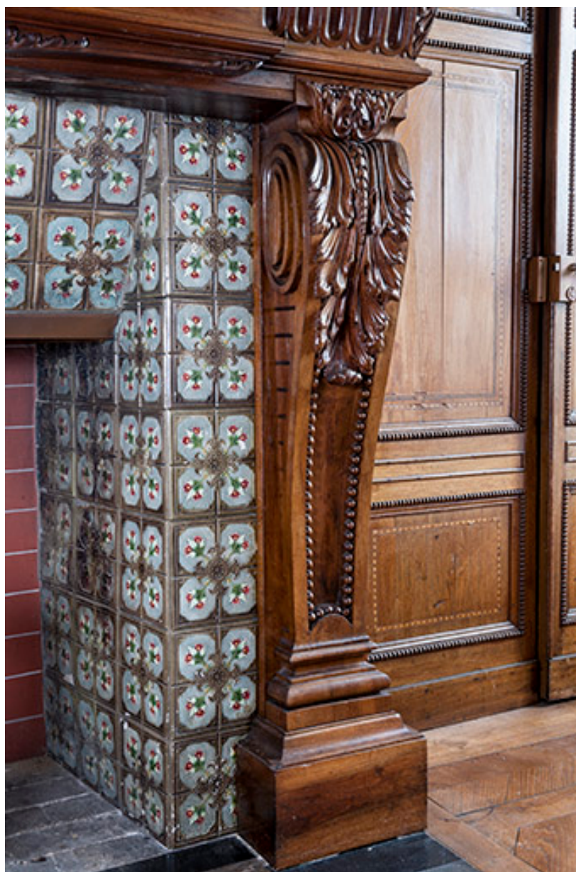
Détail du pied-droit de la cheminée.
