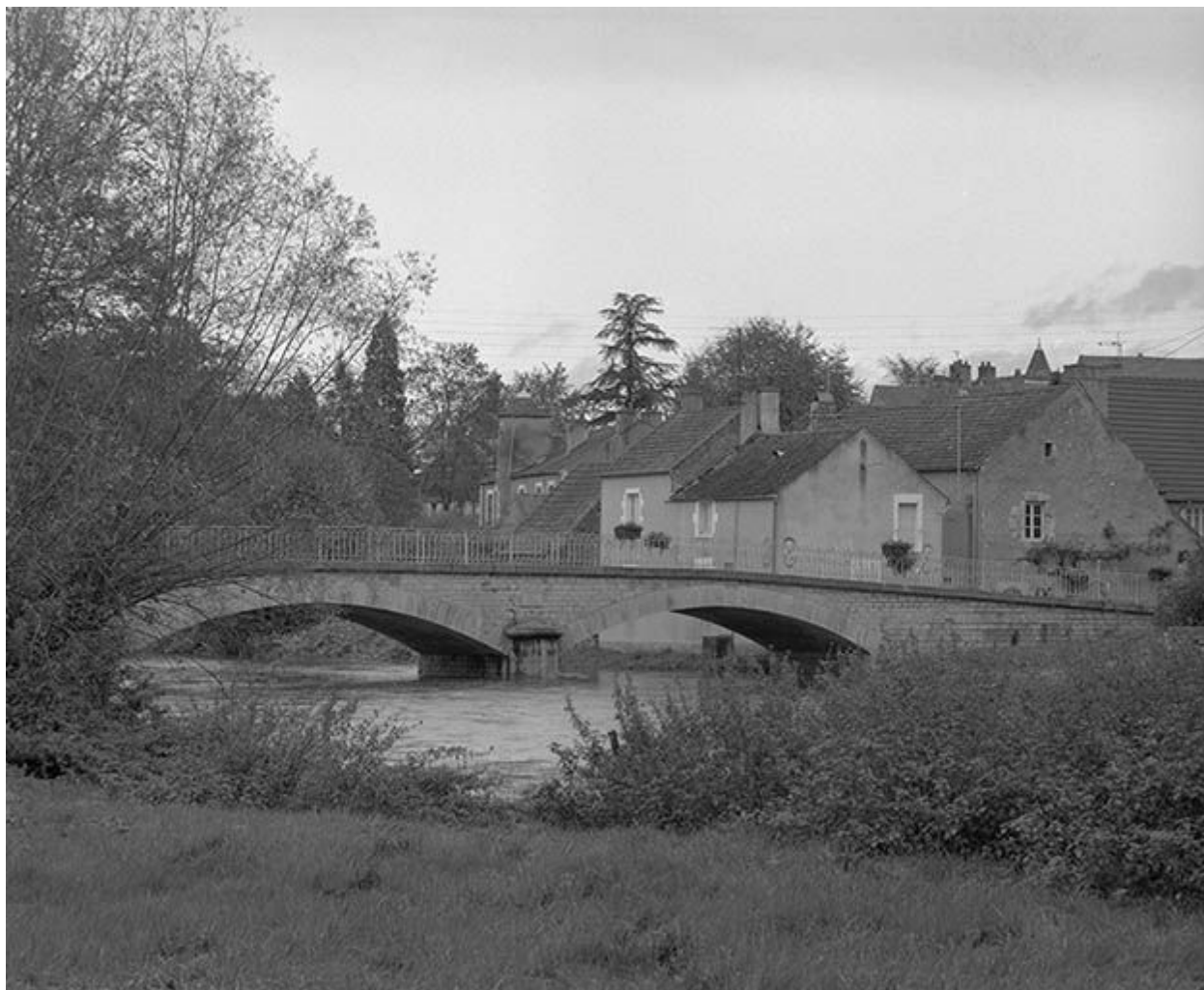
Vue d'ensemble prise de l'amont.
