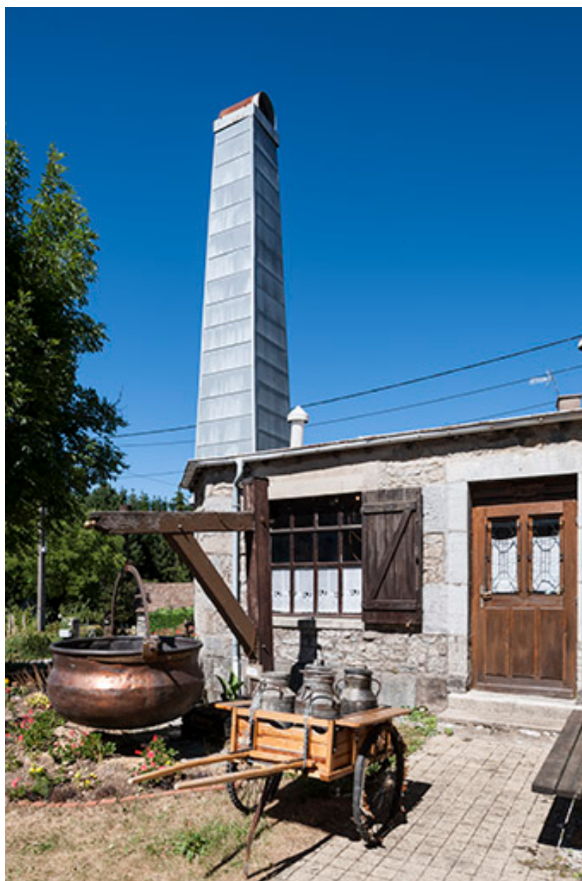
Façade ouest de l'atelier de la fromagerie.
