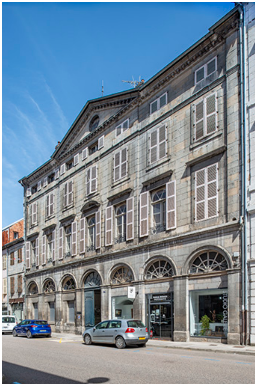
Facade antérieure vue de trois quarts droite.
