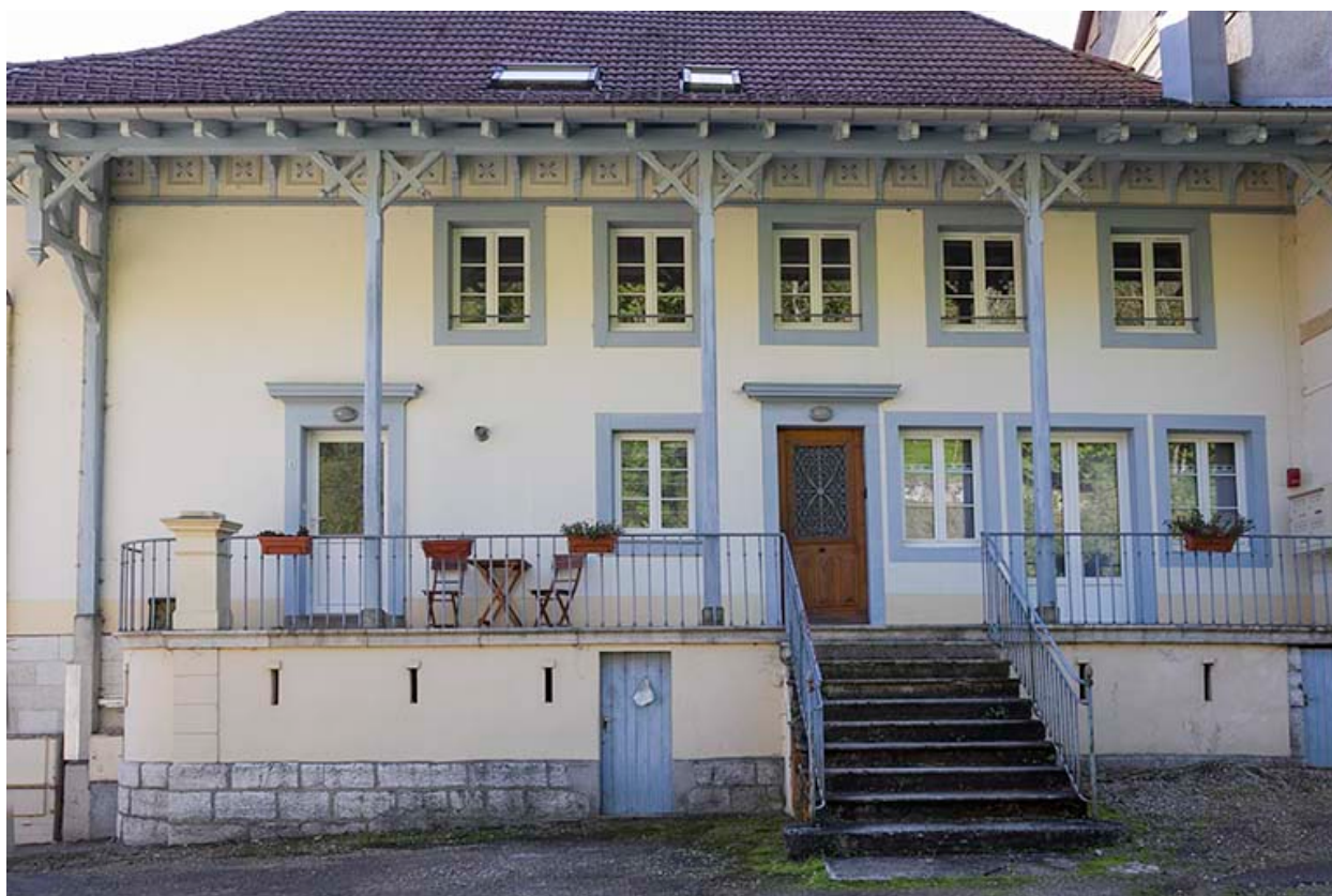
Premier atelier de fabrication : façade antérieure.
