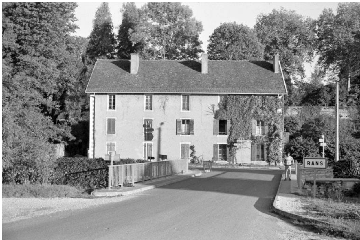
Façade antérieure du logement d'ouvriers (J).
