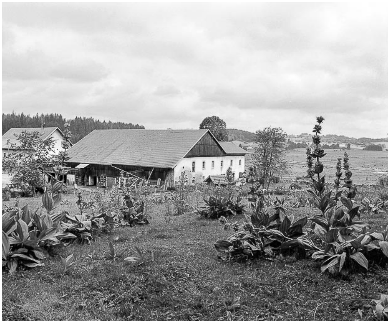
Façades antérieure et latérale gauche.
