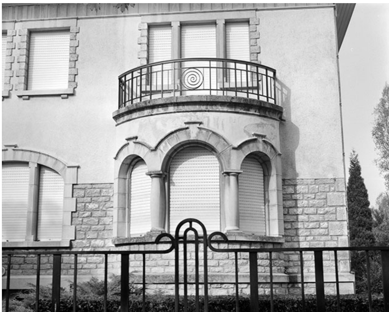
Détail : la logette du 16 avenue Albert 1er.
