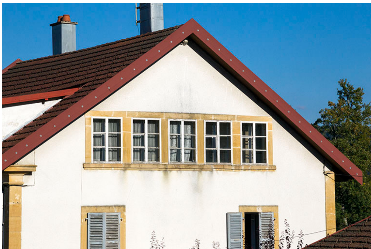
Pignon occidental : fenêtres multiples.
