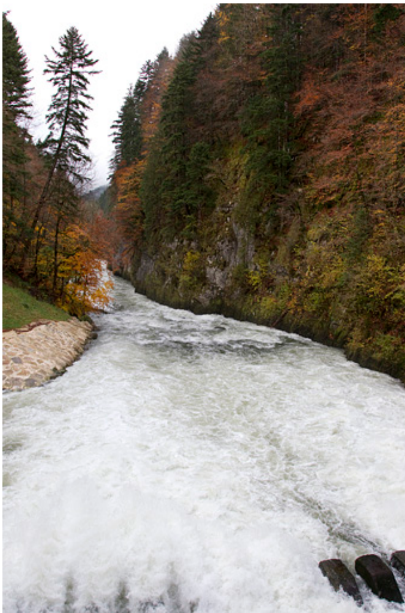
Le Doubs en aval des vannes toit.
