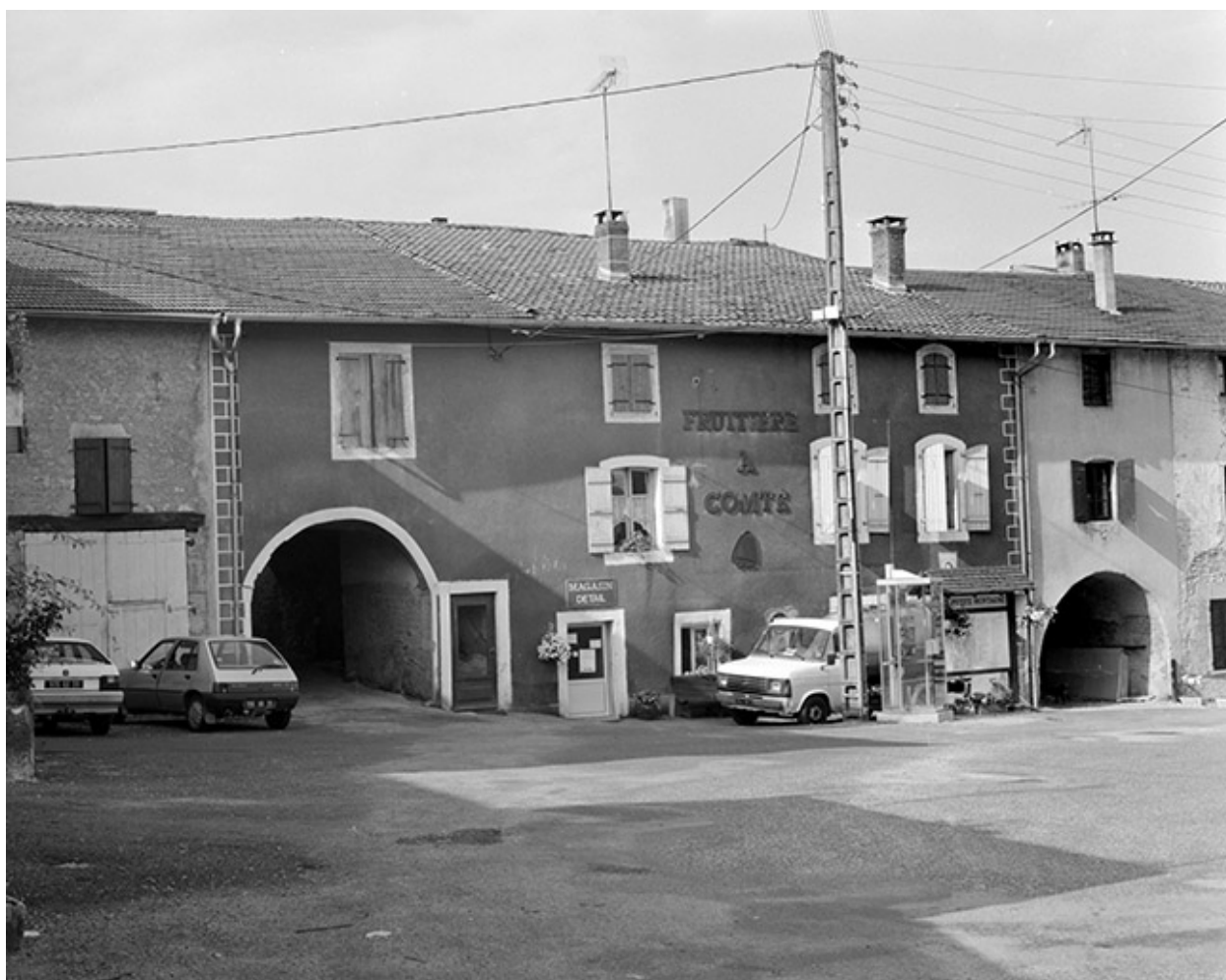
Vue d'ensemble de la façade antérieure.
