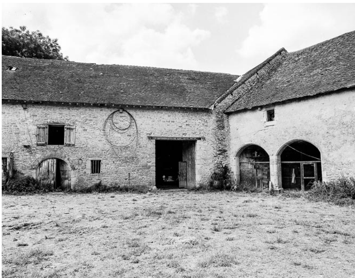
Partie agricole : façade sur cour.
