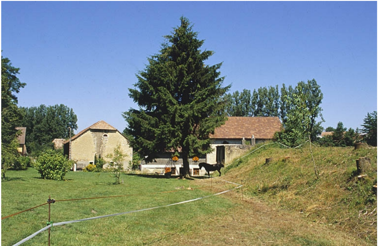
Façade postérieure du moulin et canal d'amenée.
