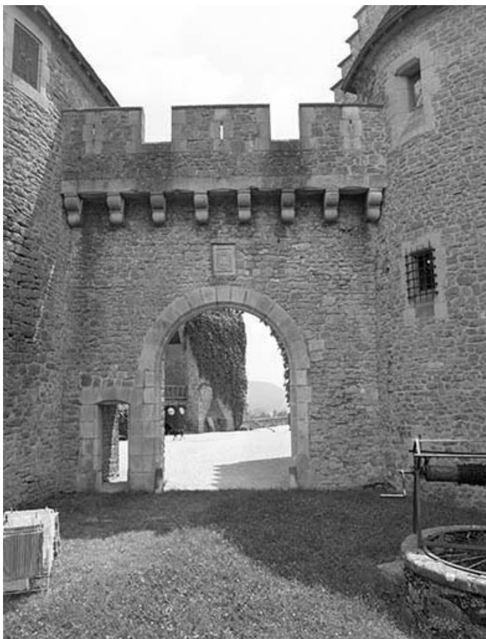
Portail nord : vue de face.
