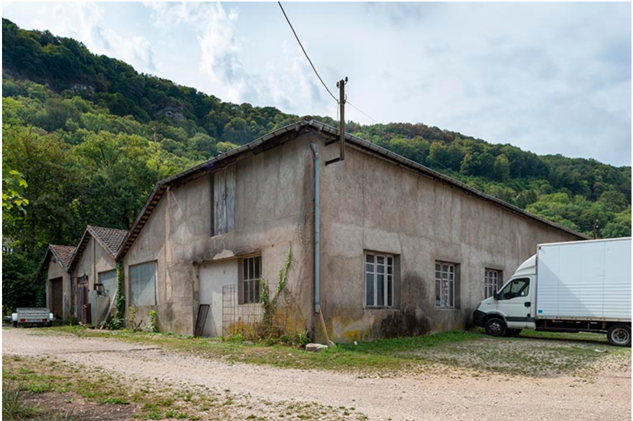
Garages et entrepôts industriels (faïencerie).
