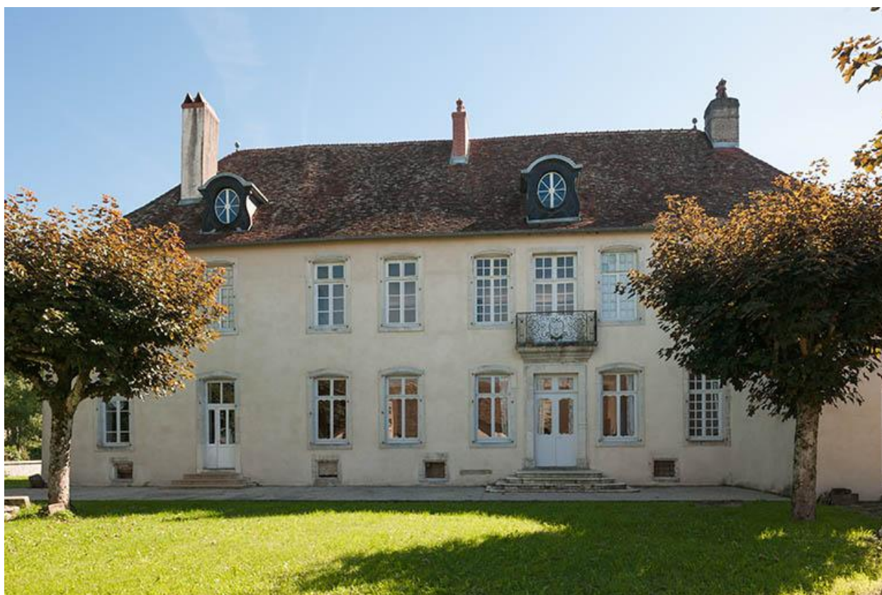
Demeure 13 rue Ménans, façade nord
