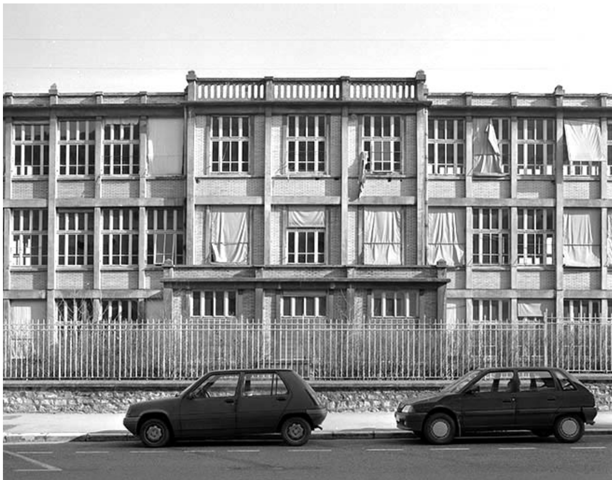
Détail de la façade antérieure (bâtiment 2c).
