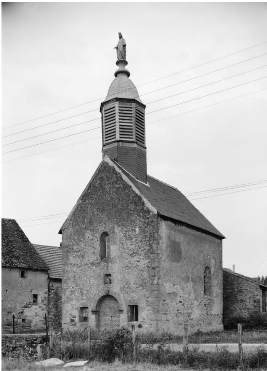
Façade et mur droit.
