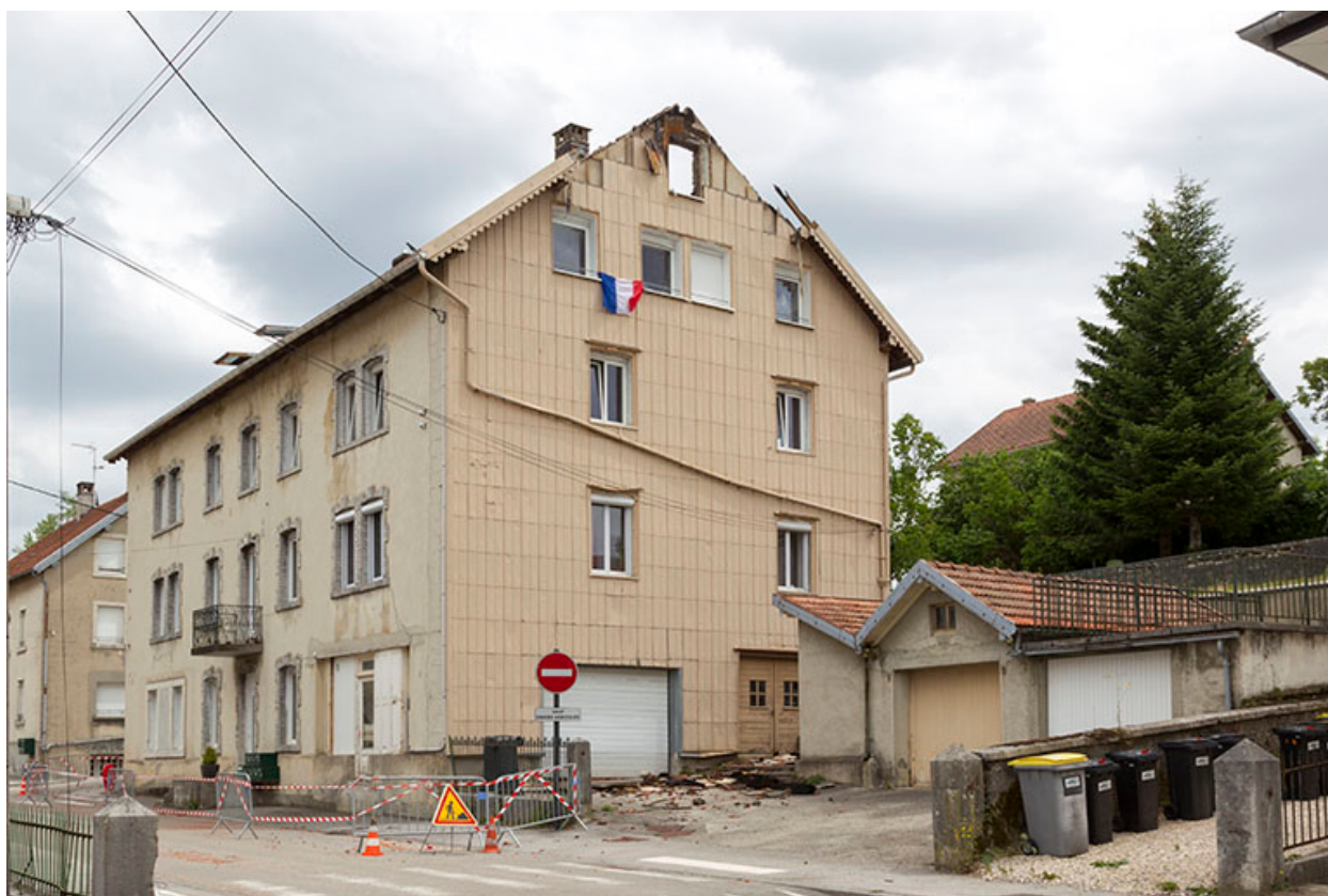
Façades antérieure et latérale droite.
