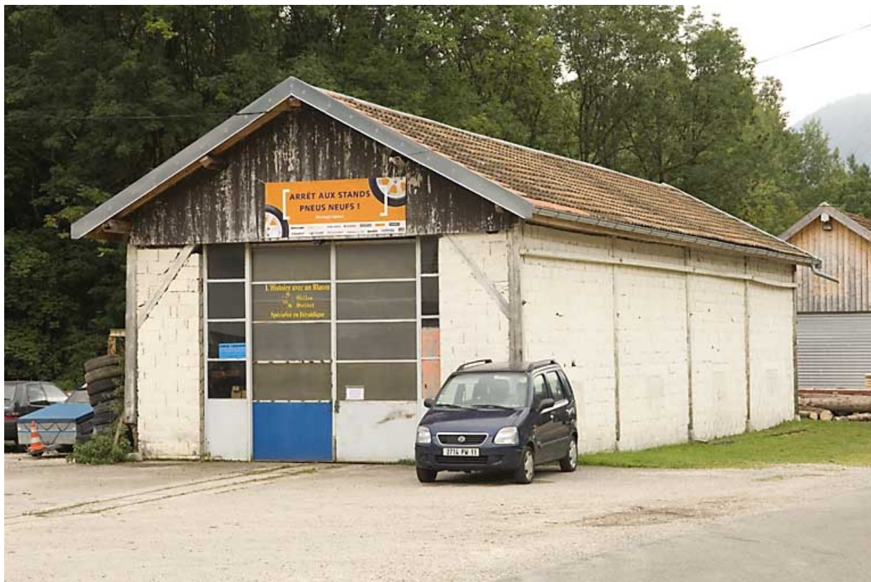
Partie sud : 1er bâtiment.
