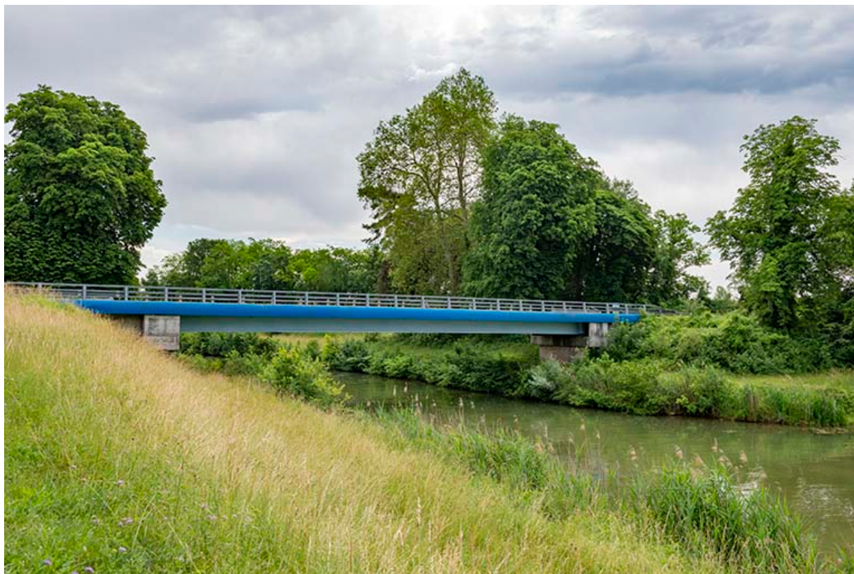
Pont routier enjambeant la dérivation.
