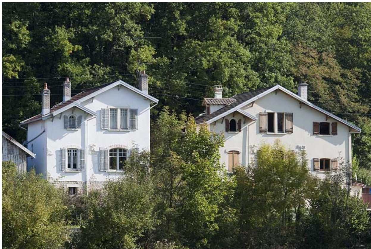
Maisons individuelles vues depuis l'ouest.
