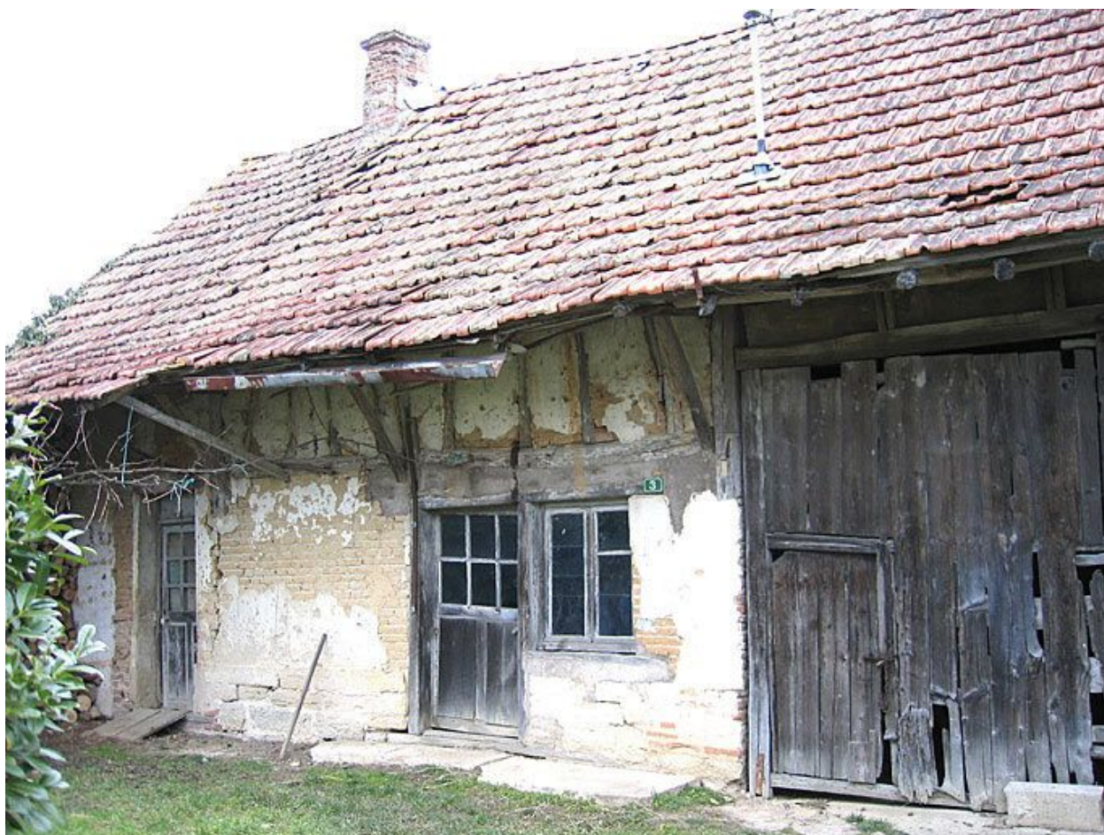
Vue d'ensemble de la façade.
