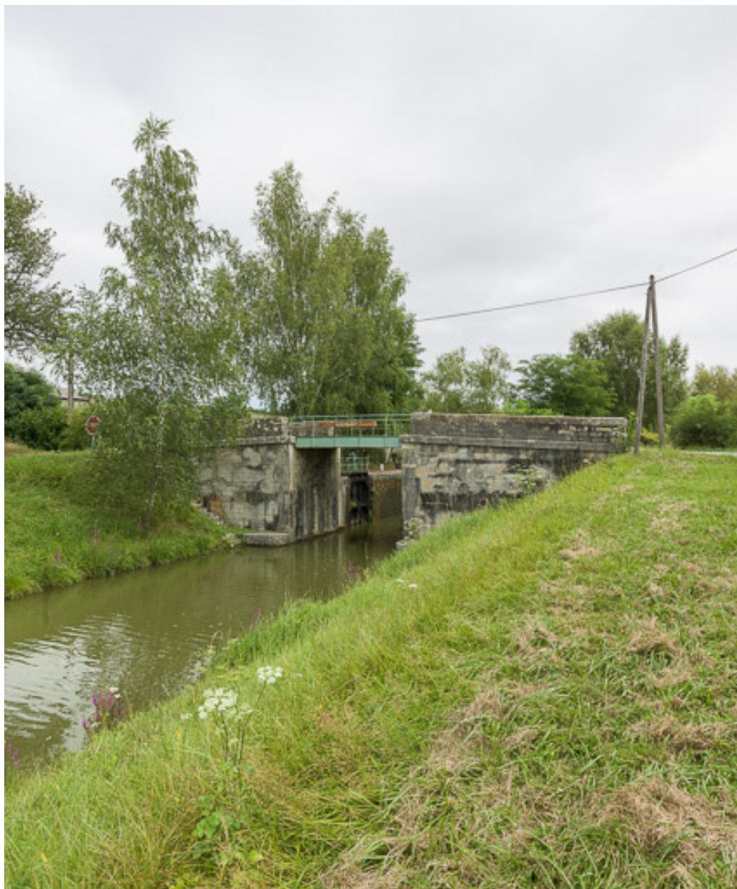
Vue d'ensemble du pont.
