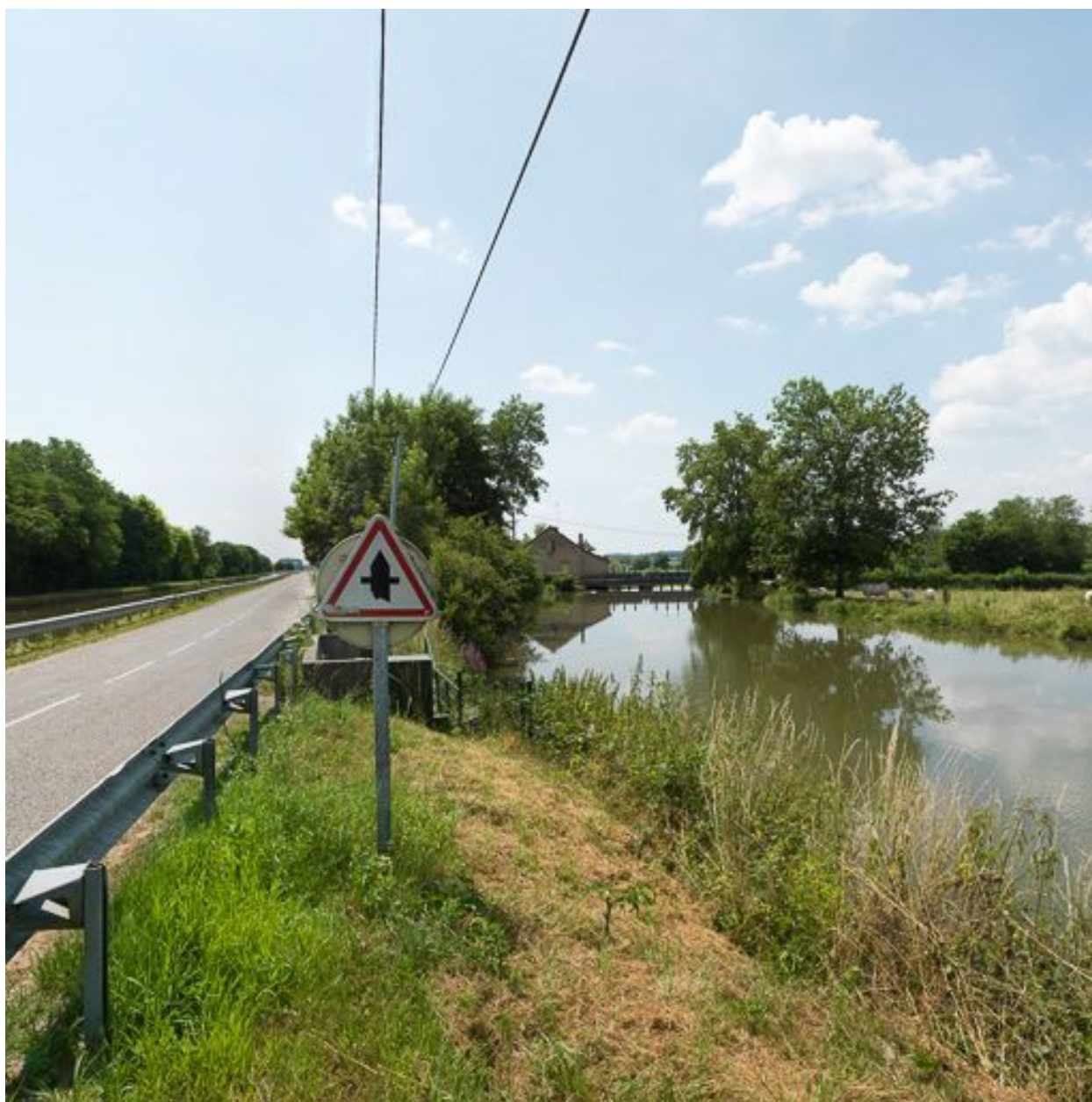
Détail de l'aqueduc.
