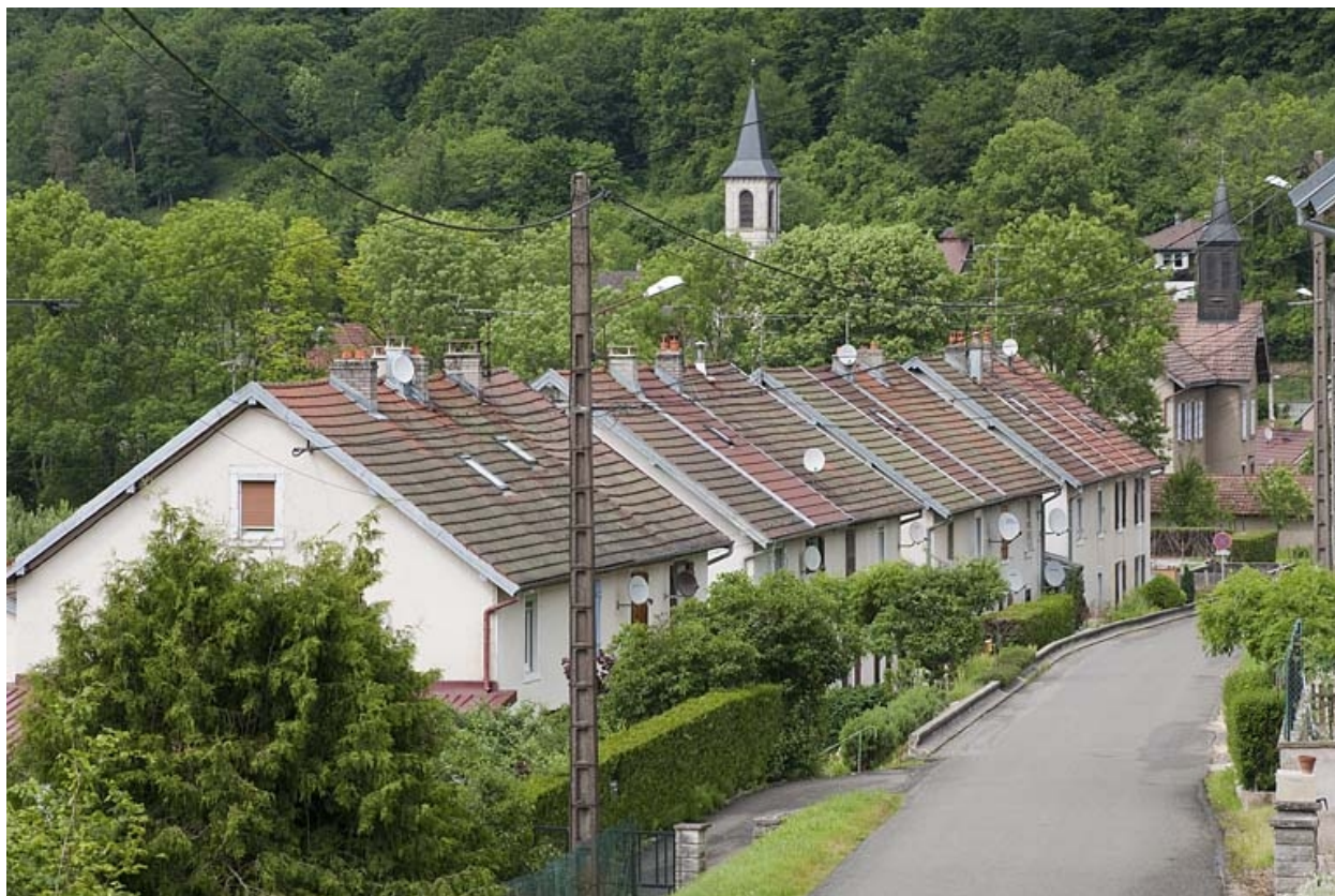
Logements ouvriers depuis le sud.
