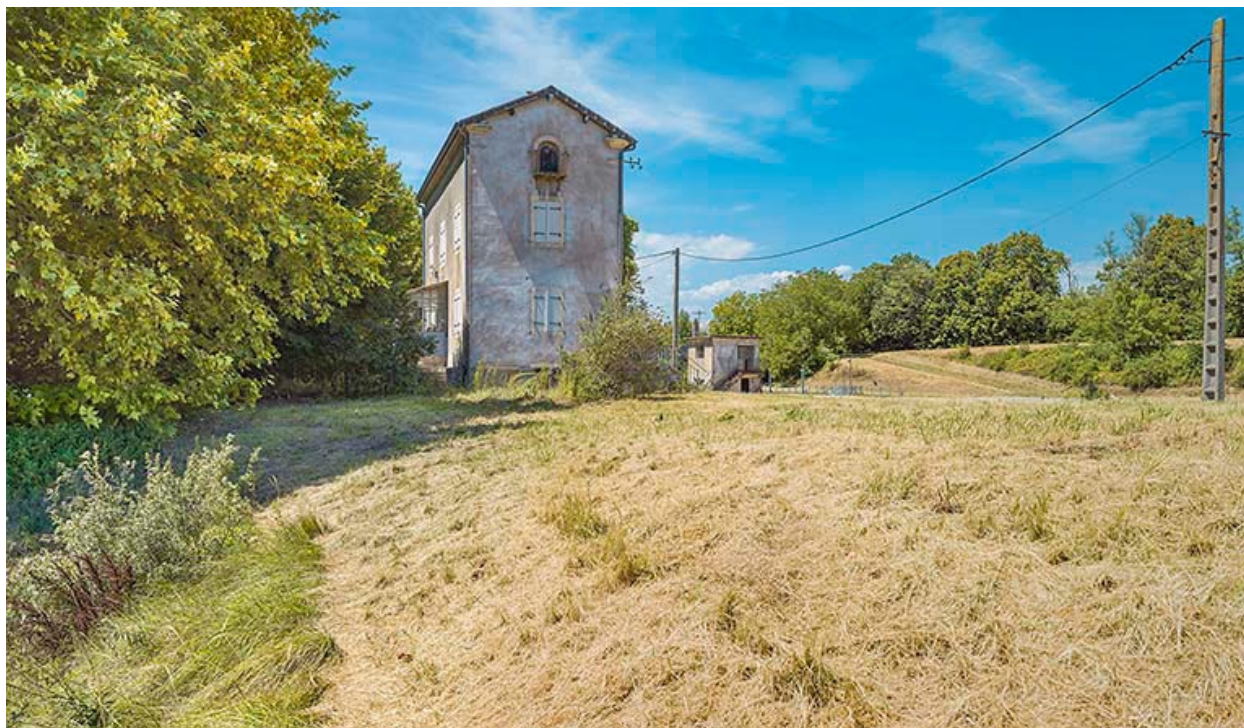
Pignon de la maison éclésièr.
